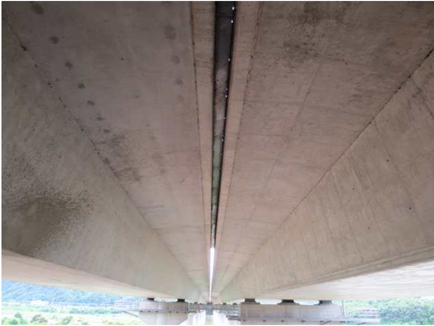
바닥판하면 및 PSC박스 외부전경
